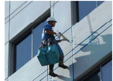
シーリング打ち状況
