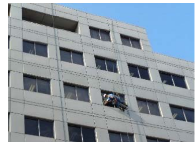
ブランク作業によるシーリング打ち換え
