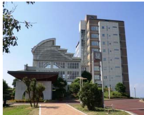
外壁診断を行った建物
