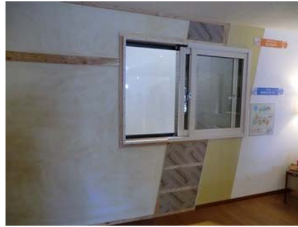
断熱改修リフォーム
