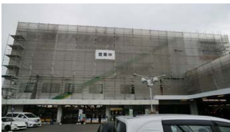
大規模店改装現場
