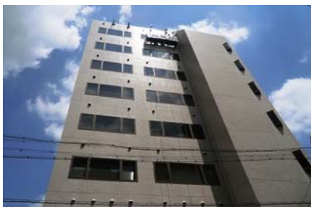
ビル改修現場 仮設ゴンドラによる作業風景
