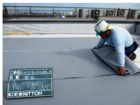
塩ビシートの敷き込み状況
