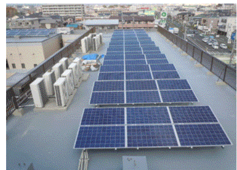
太陽光パネル取付後の状況
