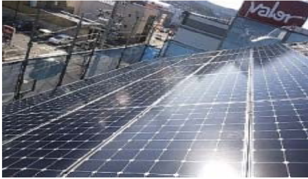
太陽光設置後
