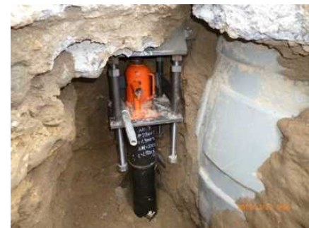
基礎沈下修正
