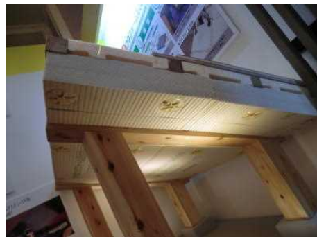
床下断熱工事
