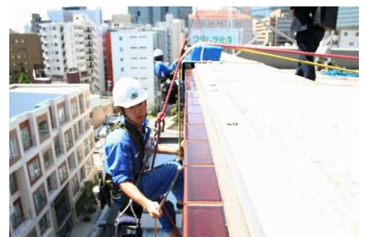
外壁診断調査中
