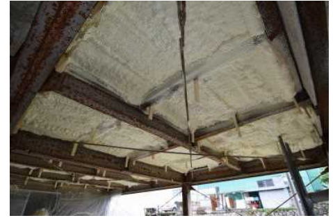
床下断熱施工後
