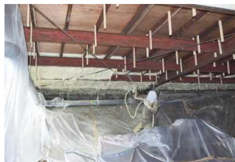
床下断熱施工状況
