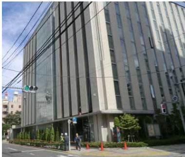
ブランコでの外壁補修
