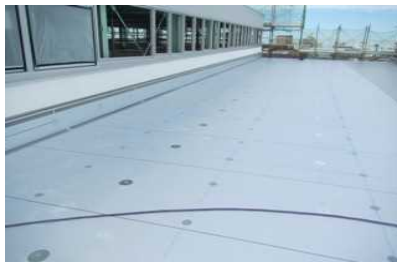
JR東海・断熱敷設
