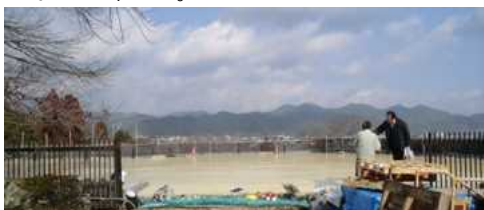
法輪寺施工状況
