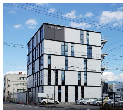
新本社完成間近
