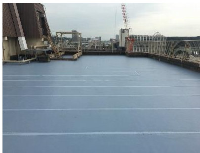
2. 通期シート施工
