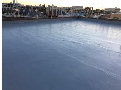
3. トップコート施工
