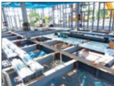
▲東京西事業所 工事風景
